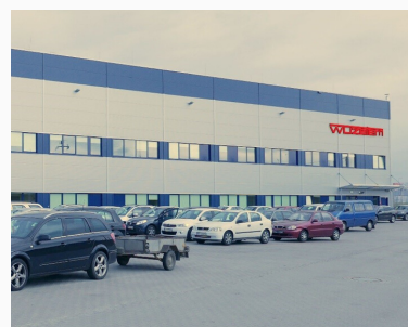
Budynek WUZETEM z zewnątrz
